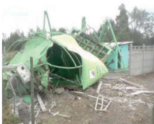
FIGURA 9.5. ESTANQUE DE AGUA DAÑADO.
