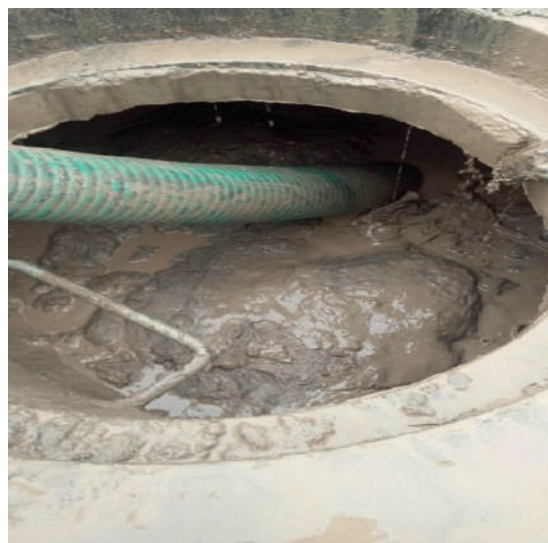
FIGURA 9.7. CÁMARA DE COLECTOR EMBANCADO EN COPIAPÓ
