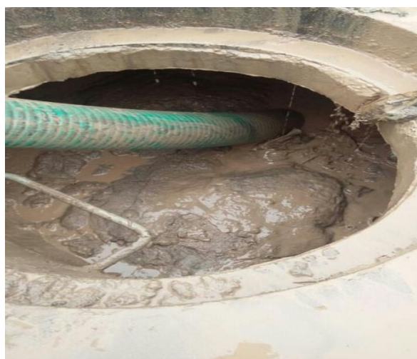
Figura 9.7. Cámara de colector embancado en Copiapó
