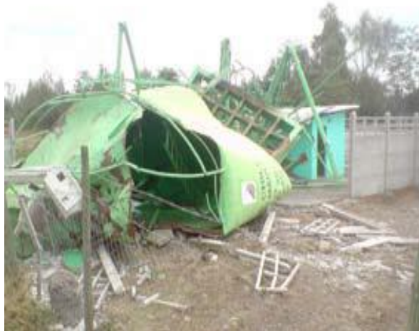
Figura 9.5. Estanque de agua dañado.
