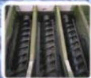
Bombas Tornillo de Arquímedes
