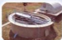
Sedimentadores Circulares
