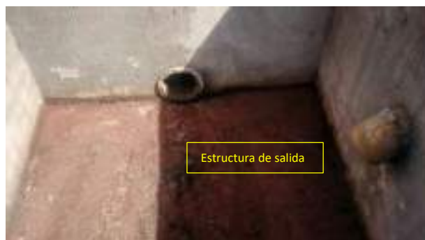
Fotografía 10. Depósito 2 – Interior estructura de salida (Ago/2017)
