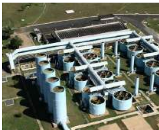
Figura 2. Vista superior da ETA Pipiripau.
