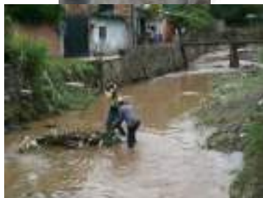
Fotografía 1. Drenaje con descarga a río o barranca
