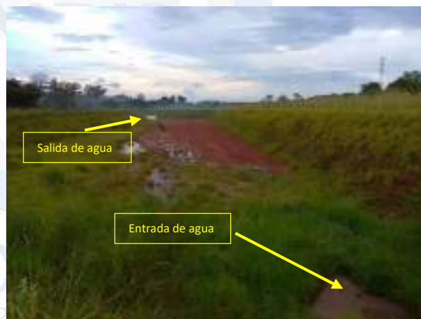
Fotografía 8. Depósito 2 – Recorrido de agua desde entrada hasta la salida (Mar/2018)
