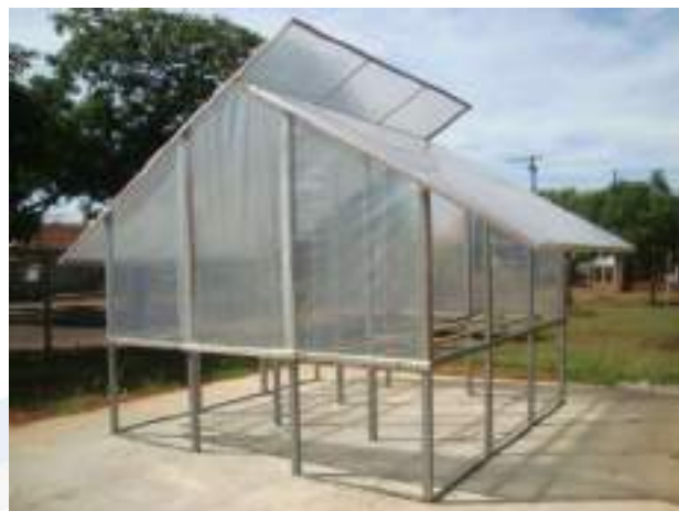
Figura 3. Estufa agrícola utilizada na secagem do lodo
