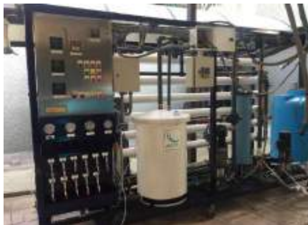
Figura 1. Planta piloto de filtración por membranas
