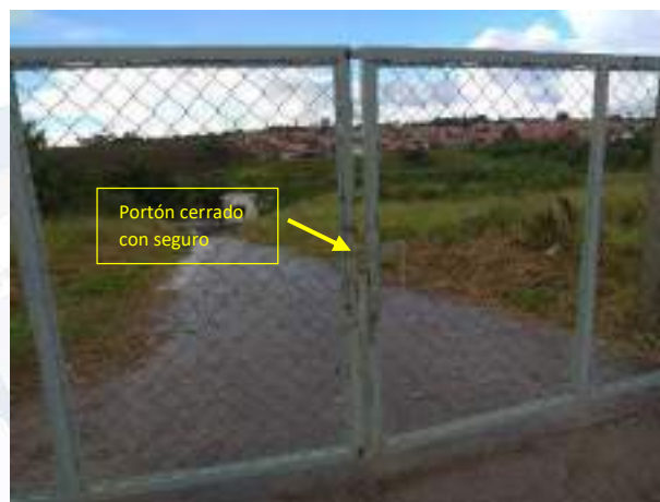
Fotografía 2. Depósito 1 - Portón de acceso (Mar/2018)
