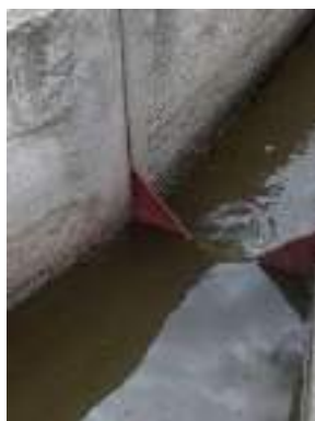
Figura 2. Vertedero de cresta delgada en la PTAR de Churuguzo
