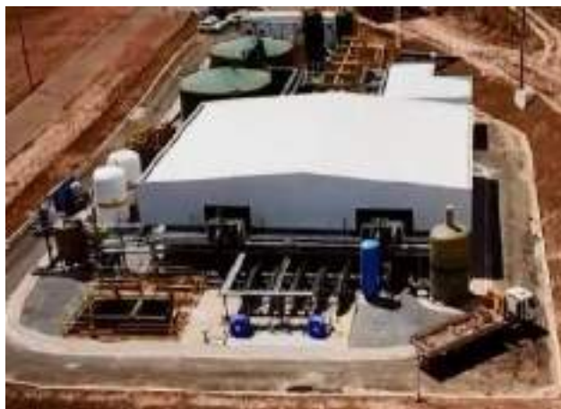
Figura 1. Vista superior da ETA Lago Norte.
