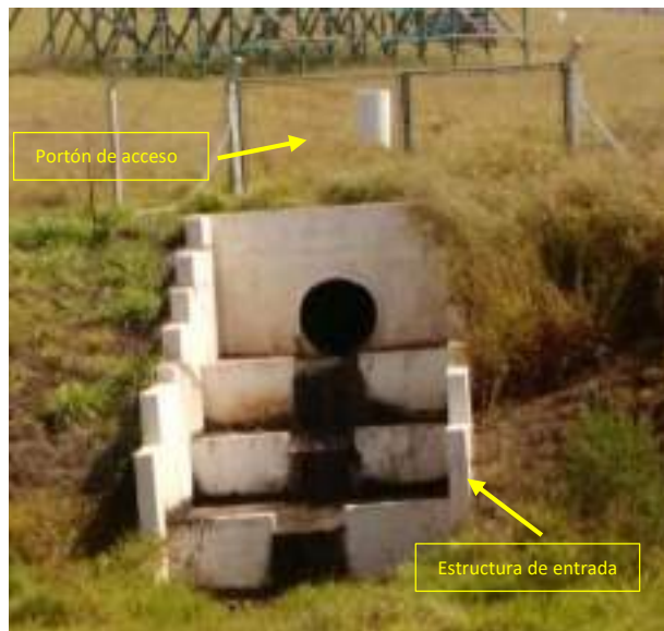
Fotografía 9. Depósito 2 – Portón de acceso (Ago/2017)
