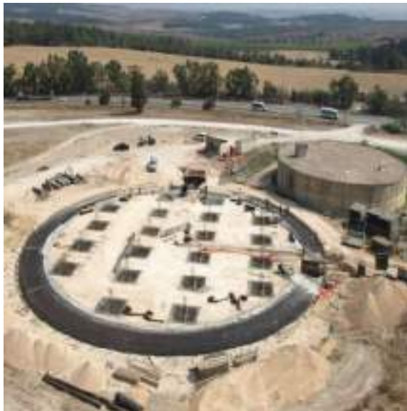
Figure 7. Reservorios con capacidad de 30,000m 3 en construcción
