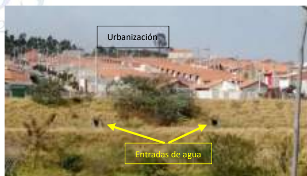
Fotografía 3. Depósito 1 – Urbanización (Ago/2017)
