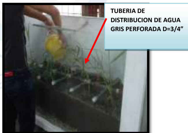
Fotografía 2. Tubería de distribución de agua gris Fuente: Autore
