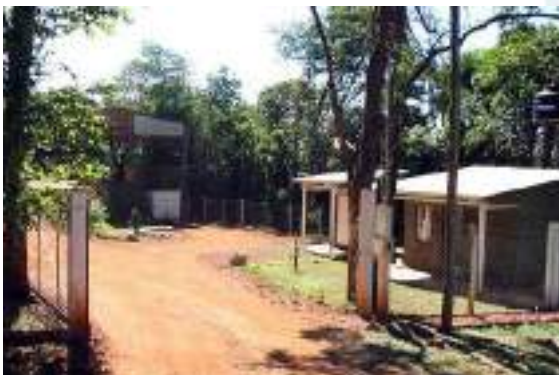
Figura 1 Estación de Transferencia Oberá
