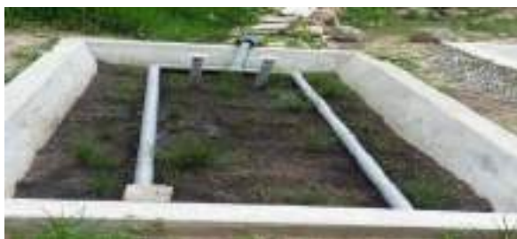
Figura 5. Humedal subsuperficial de flujo vertical con Cola de Caballo
