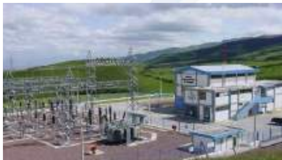
Figura 1. Central hidroeléctrica El Carmen
