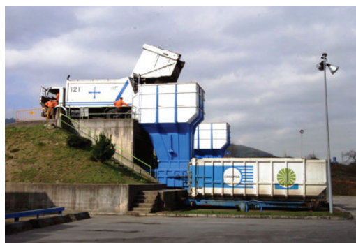
Figura 4.22 Vista de ET de descarga directa con compactación
