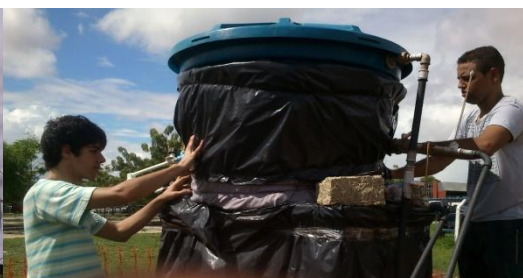
Figura 3. Reservatório com revestimento térmico
