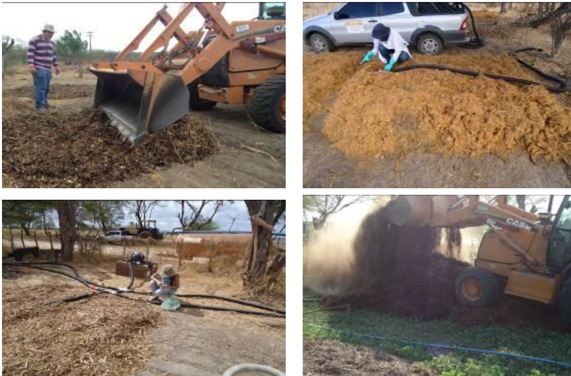
Figura 1. Montagem das leiras e sistema de aeração forçada.
